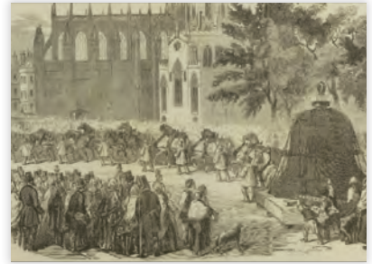
4 時計塔に吊される新しい鐘の運搬作業 (November 1, 1856)
