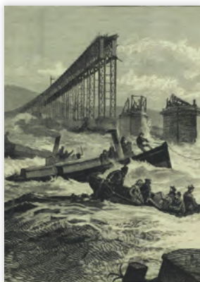
8 1年前に完成したばかりのスコットランドのテイ橋が列車走行中に強風のため崩落、乗客75人が犠牲となった (January 10, 1880)
