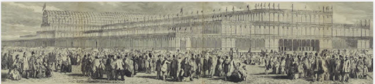
2 ジョゼフ・パクストン設計の鉄とガラスの建築、クリスタル・パレス (August 2, 1851)
