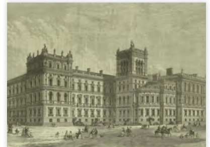
9 完成途上の外務省ビルのセント・ジェームズ・パークに面する正面。設計はゴシック・リヴァイヴァルを先導した建築家ギルバート・スコット。ゴシック様式による設計案がパーマストン首相の不興を買うと、外務省ビルの建築家としての名前を後世に残すために、涙を飲んでルネサンス様式で設計した (October 6, 1866)
