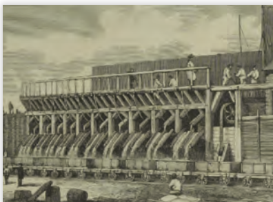
5 大臭気を契機にテムズ川沿岸に整備さ れた大排水路 (November 30, 1861)
