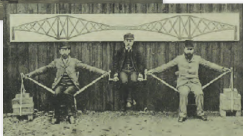
5 フォース川の河口兩岸が最接近するエジンバラ西部のクウィーンズフェリーに建設された鉄橋。下は橋の力学原理を示すためカンチレバーに座る人々 (October 19, 1889)
